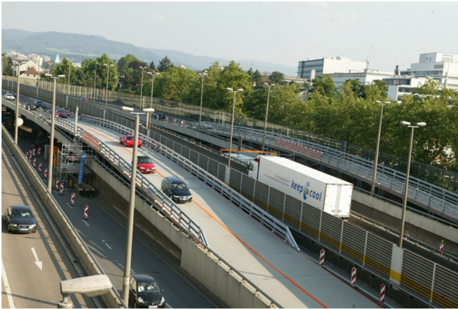
Die Fly Over-Rampe auf der Bäumlhofbrücke in Basel(2010) Hilfsbrücke für Arbeiten auf der Fahrbahn ohne Verkehrsbehinderungen
